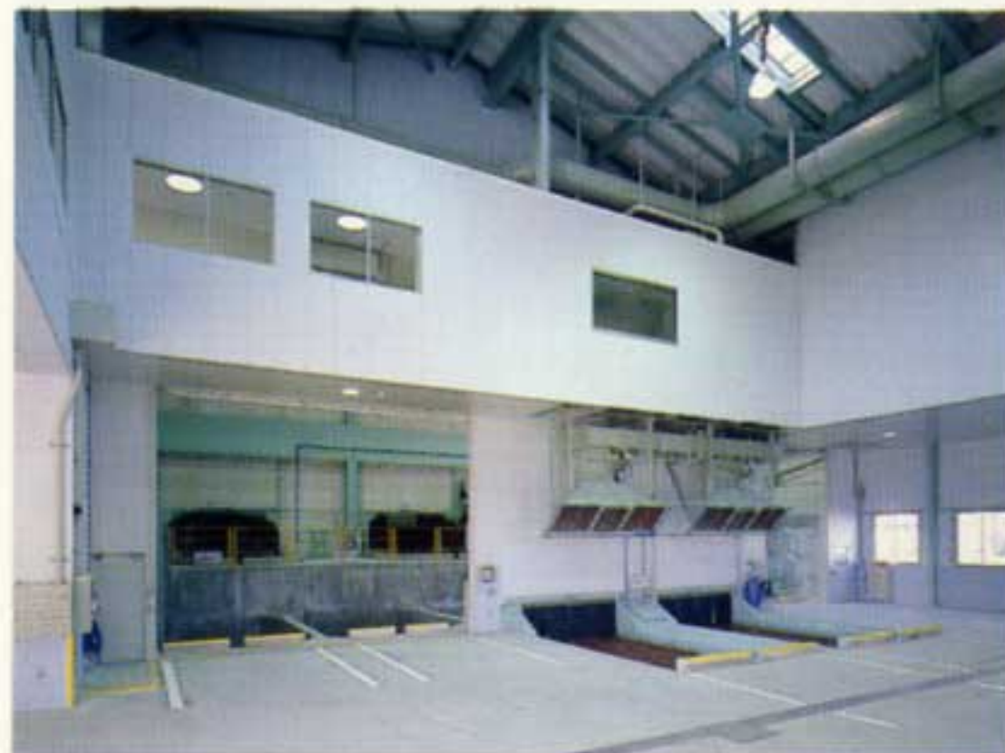
▲プラットフォーム ごみ収集車両による投入作業が容易で安全に行える所。
